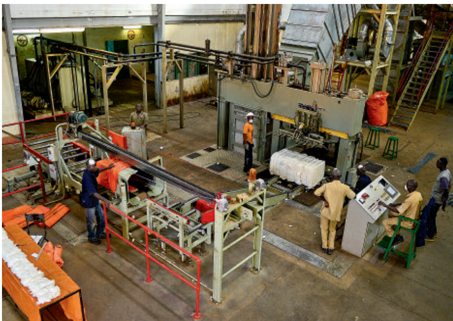
Bei der Modernisierung der Verarbeitungsanlagen gab es Nachholbedarf.
